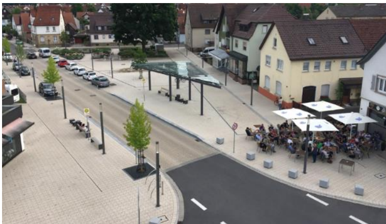
Umfangreiche Stadterneuerung in der Stadtmitte von Renningen. Zur Weiterentwicklung wurde der Rahmenplan Stadtmitte/Bahnhofstraße erarbeitet und vom Gemeinderat beschlossen.
