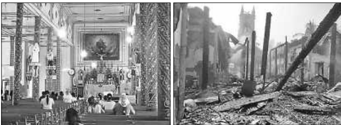
Die Kirche vor und nach dem Brand
