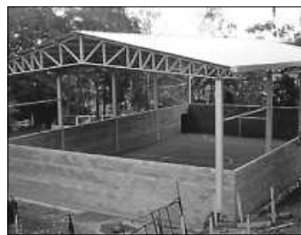
Die Turnhalle wurde mit Renninger Hilfe gebaut Foto: Embu
