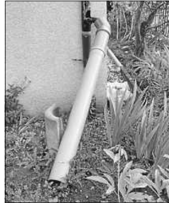
Wasser nicht in die Kanalisation sondern in den Garten ableiten Foto: H.-P.Kuhlmann
