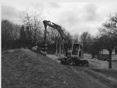
Die Fundamente wurden vorbereitet...
