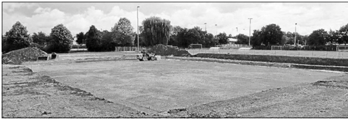
Vorher, während der Bauarbeiten auf der Freizeitanlage Hirschländer im Sommer 2020. Bild: Stadt Renningen.
