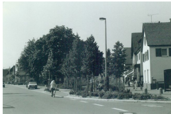
Abbildung 18: Ernst-Bauer-Platz vor der Umgestaltung, Blick von der Bahnhofstraße (Quelle: Stadt Renningen)
