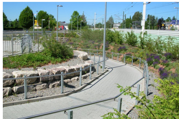
Abbildung 63: Unterführung zum Gewerbegebiet
